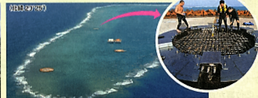
⑤日本の南端(東京都) 島が波によってけずられるのを防ぐため、堤防(島)とふたで保護しています。
