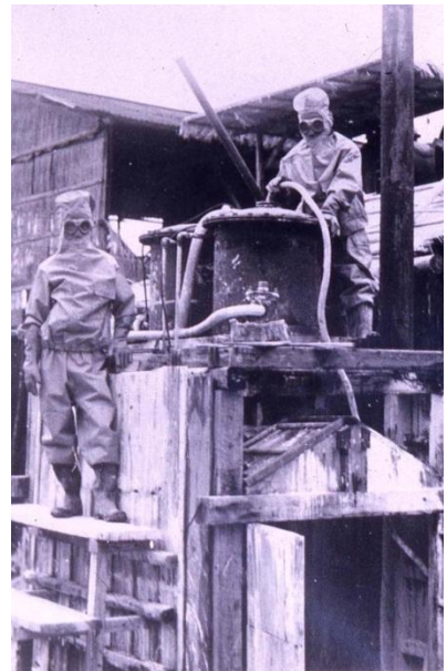
当時の作業風景
