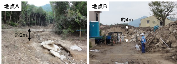
図 12 現地写真（2014年9月3日撮影）
