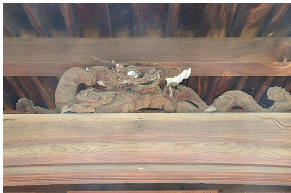
図1 龍岸寺本堂の竜の彫刻 出典：「浄土宗 龍岸寺」
