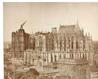
図2-17 ケルン大聖堂完成事業が進行中の光景
