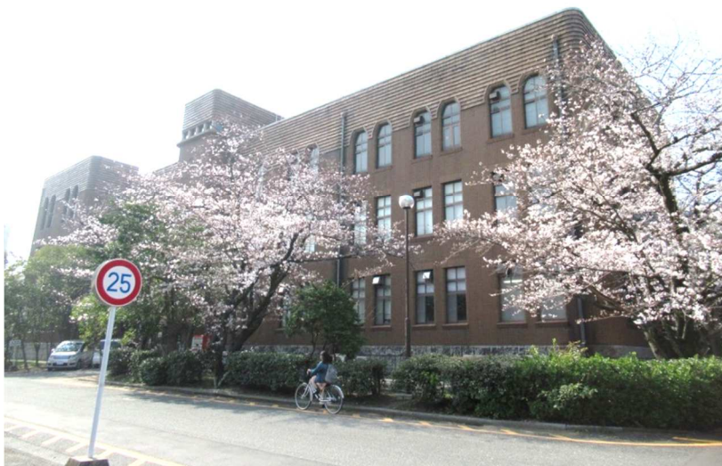
【写真1】旧工学部本館(側面より撮影)
