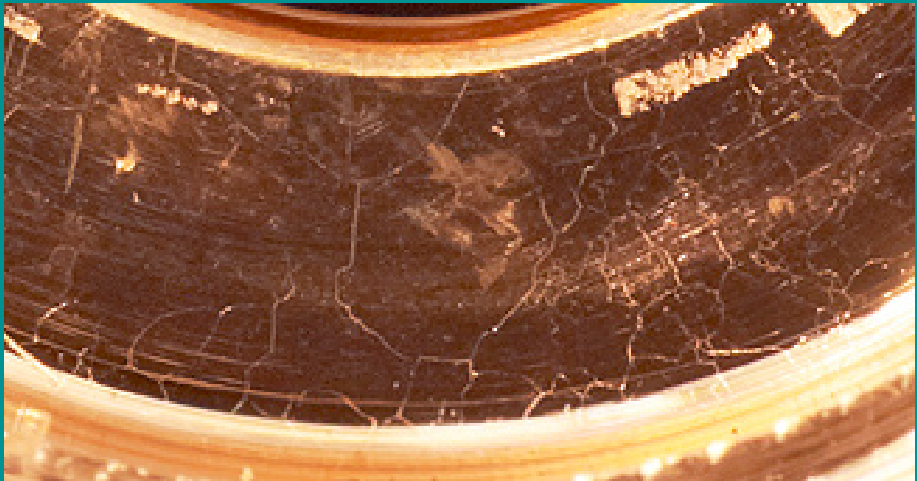
参考；RF空洞のカソード側の外面
