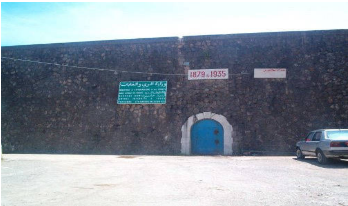
Photo 1 : l'entrée du barrage de Hamiz.
