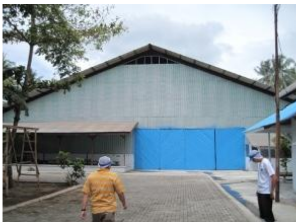
カツオ節工場の外観
