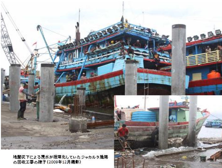
写真2 地盤沈下による水位上昇、かさ上げ改修の様子
